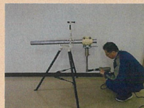
下面からの穿孔 (方向変更アダプタを使用)
