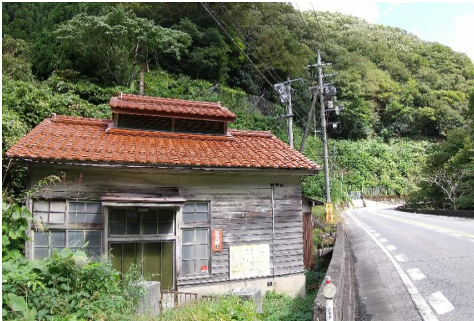
更新工事前の根雨発電所
